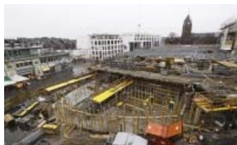
Anna Schwartz Die Bauarbeiten für „Sass am Markt“ laufen trotz des harten Winters nach Plan.
